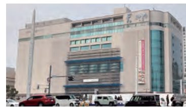
(中央図書館移転のため工事整備が行われているエールエールA館)
